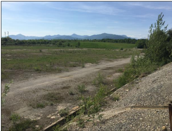
Parcelle OG n°1291 avec le mur de soutènement
